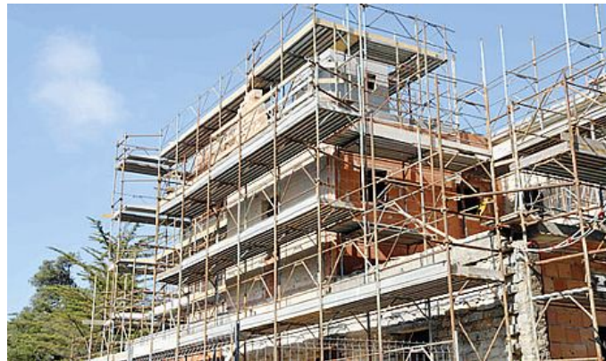
Un cantiere edile
