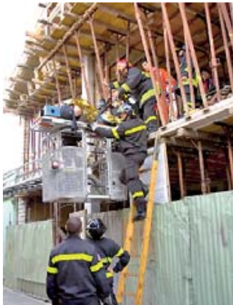
Soccorso in un cantiere
