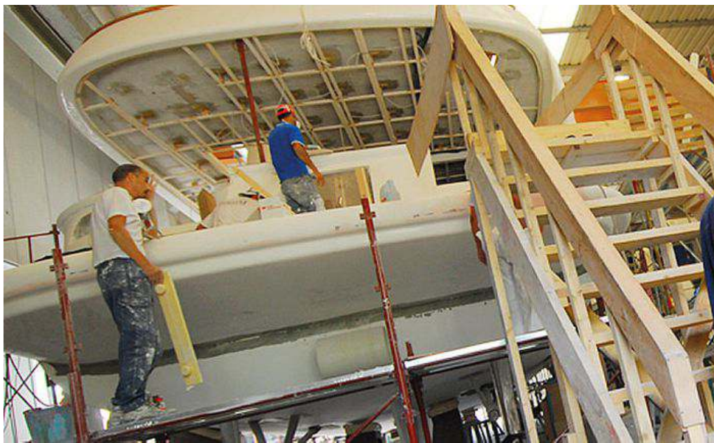
Un cantiere nautico ad Arbatax
