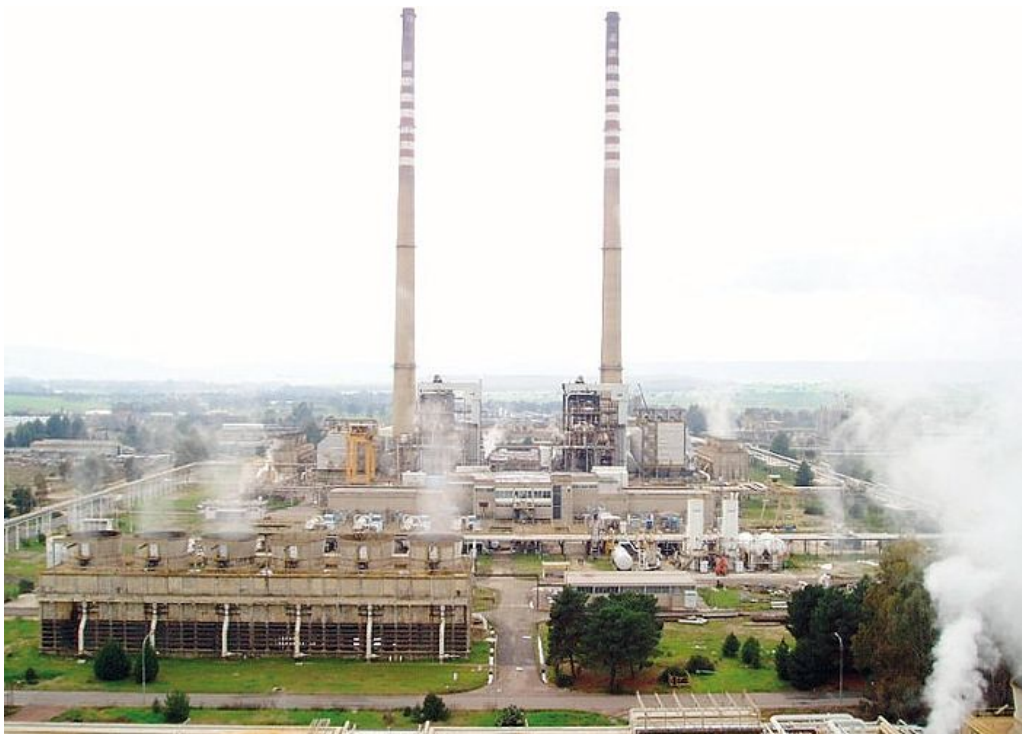
La centrale elettrica di Ottana
